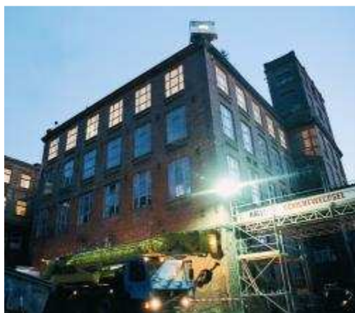
Halle 14 im Gelände der Baumwollspinnerei.
